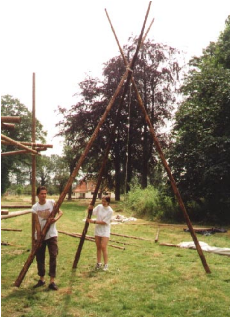
Figuur 15: Eén van de balken wordt opzij geschoven
