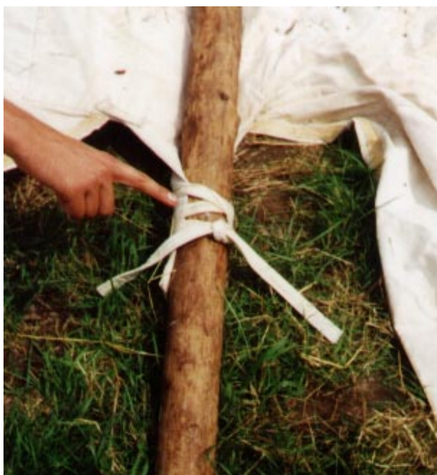
Figuur 19: Nagel tegen het wegglijden
