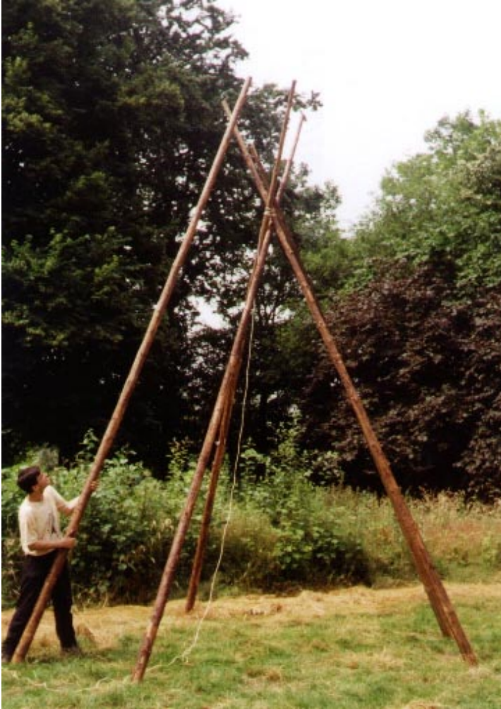
Figuur 16: Tussenvoegen van balken
