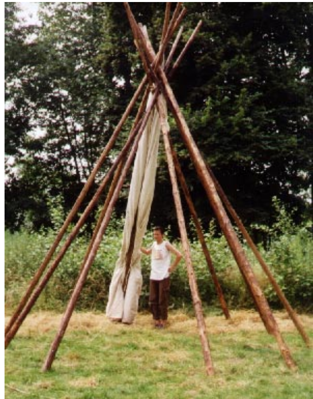
Figuur 21: Plaatsen van de paal tegen de constructie
